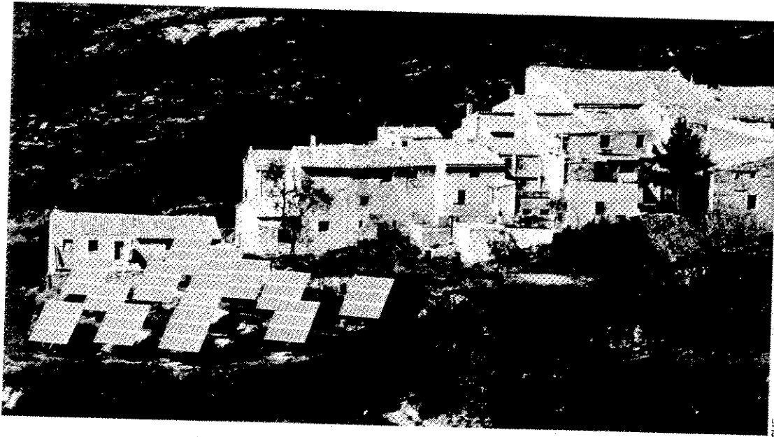
Panneaux solaires dans une commune rurale, en Espagne.
